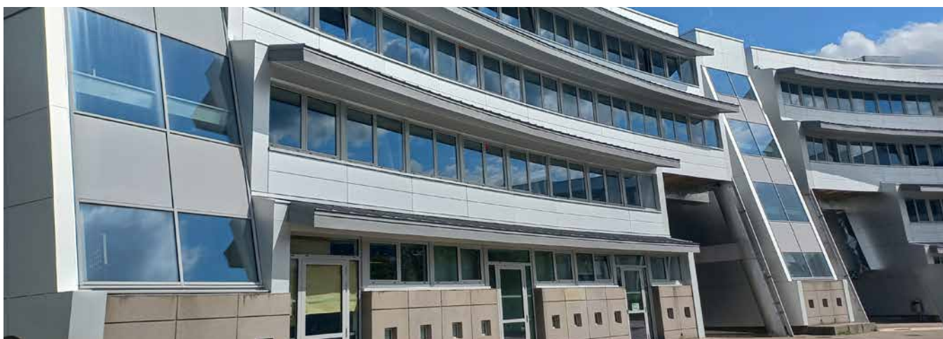
Travaux sur un compartiment de la façade intérieure (murs rideaux et façades des salles de classe) – Nov. 2024
