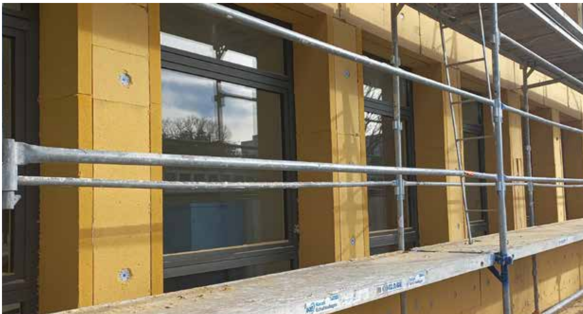
Isolation par l'extérieur d'une façade en laine de bois, après remplacement de menuiseries et traitement des encadrements de baies.
