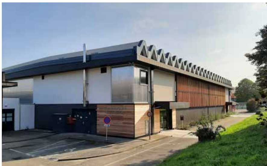
Gymnase Pierre de Coubertin après rénovation, bâtiment comportant une couverture autoportante qui a été isolée et rénovée en surcouverture.
