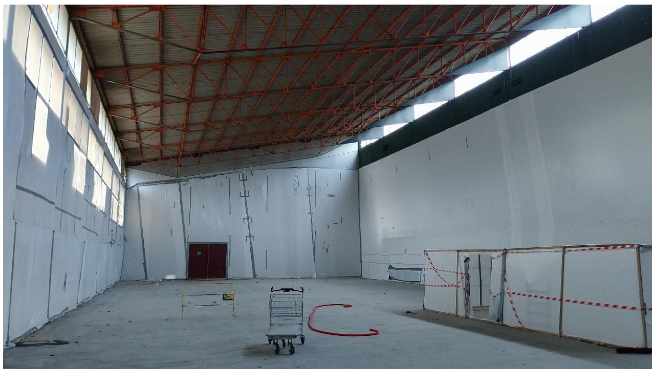
Gymnase Malherbe à Grenoble – Phase désamiantage
