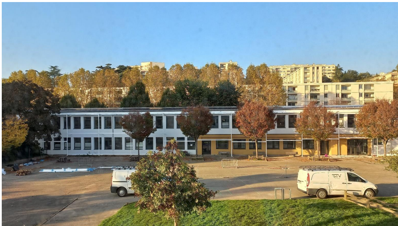
Groupe scolaire Diderot à Lyon
