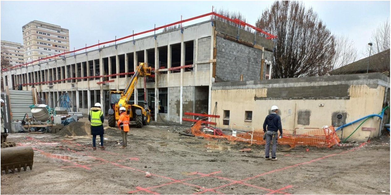
Groupe scolaire du Val des roses à Albertville
