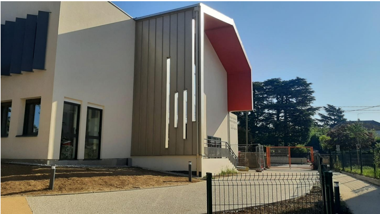
Groupe scolaire Simone Signoret à Saint-Priest (rénovation et extension)
