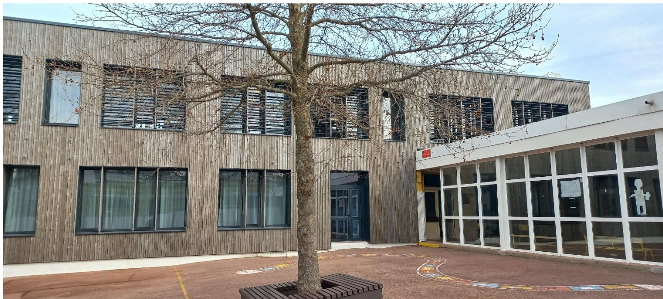
Groupe scolaire Gémeaux à Lyon
