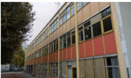
Avant travaux, l'école comportait une façade légère composée de panneaux sandwichs peu isolés et amiantés, une chaufferie fioul, et une mise aux normes était nécessaire.
